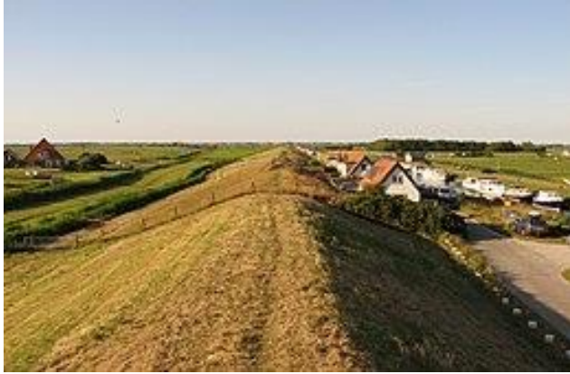
Slaperdijk achter de Hondschbossche Zeewering links
