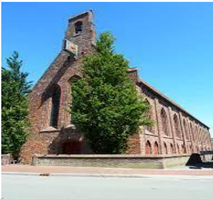
Cisterciënzer ziekenzaal te Aduard, onderdeel kloostercomplex
