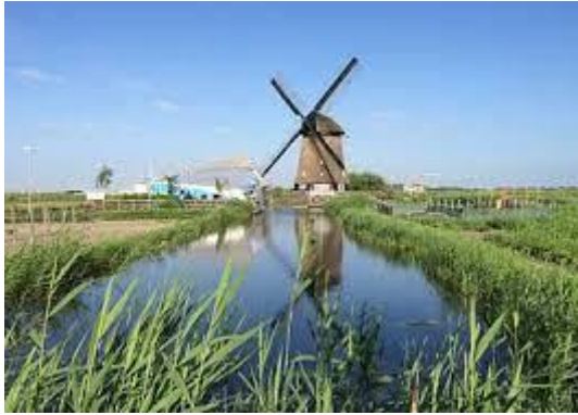
Afwateringsgang te Zuid-Scharwoude
