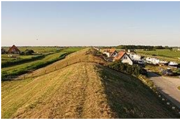
Slaperdijk achter de Hondschbossche Zeewering links
