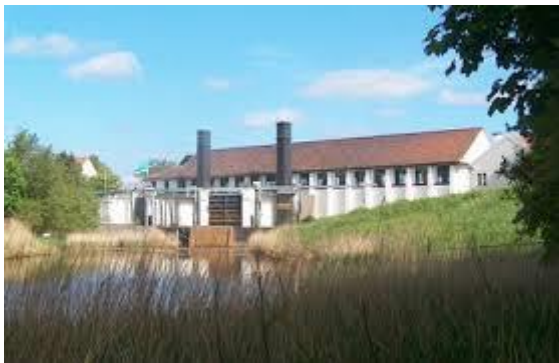
Gemaal Leemans in de Wieringermeerpolder
