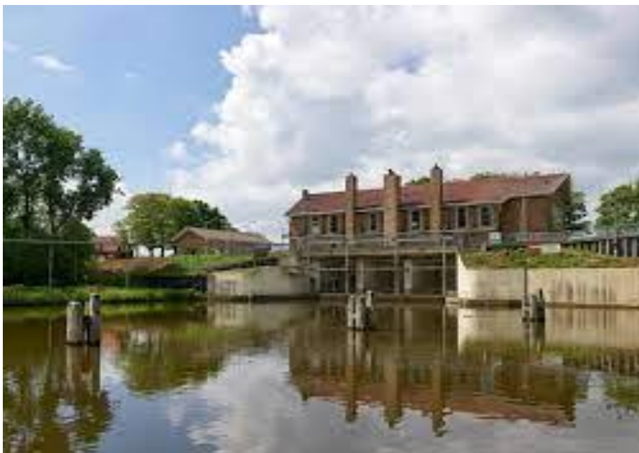
Dieselgemaal Vissering in Urk
