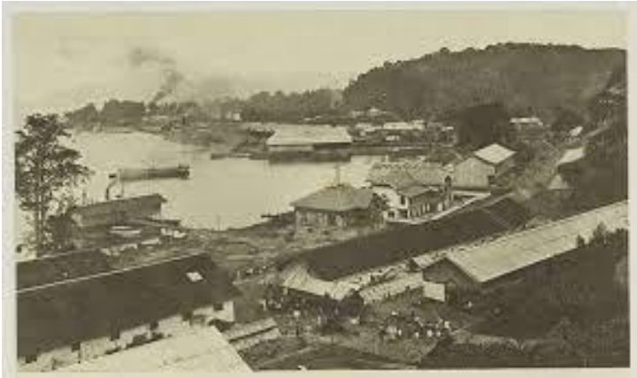
Omslag- en bunkerinstallaties Sabang
