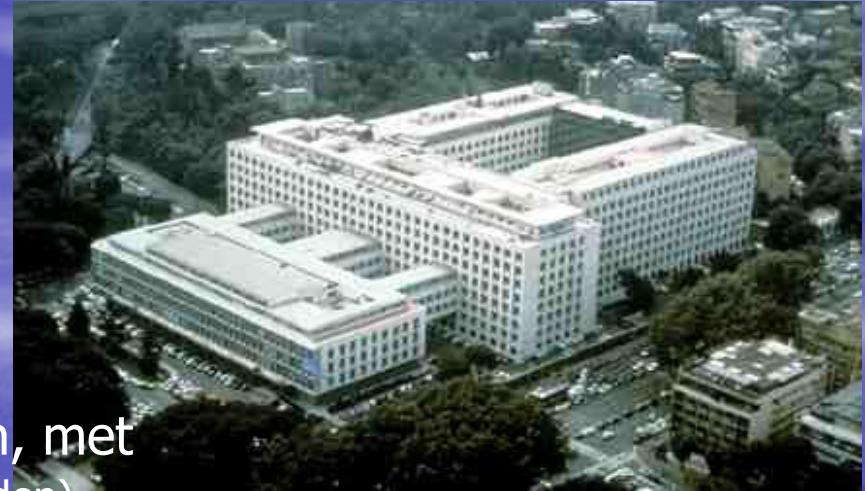
FAO gebouw Rome
