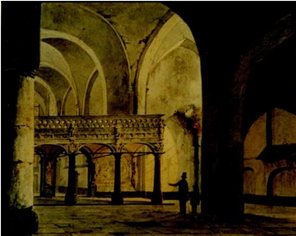
Het doxaal ter afscheiding van het priesterkoor van het schip was in het Luikse gebruikelijk
